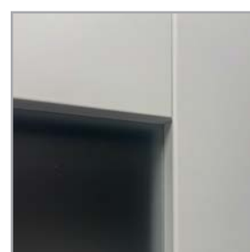
spojení svislých a vodorovných rámu
