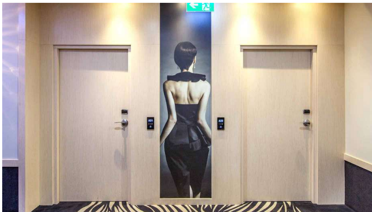
protipožární dveře FR EI30 SR 37dB, pevná dřevěná zárubeň
