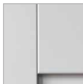
zkosení hran na spojení rámu
