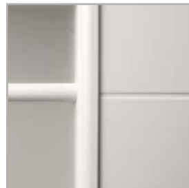
pohled na frézování
