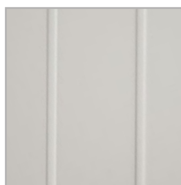
frézování na povrchu křídla
